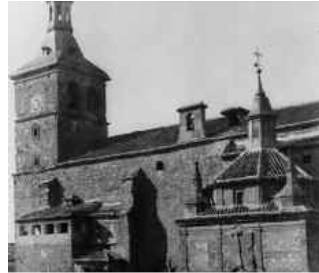
Vista parcial de la destruida iglesia parroquial de Campo de Criptana
