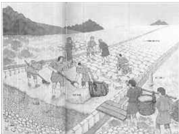
Construcción Vía de la Plata
