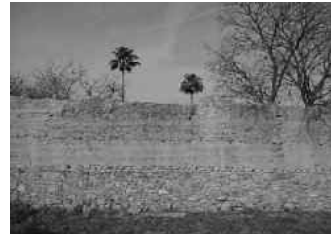
Los Callejones : detalle de un paramento realizado con una base de piedra y mortero y el resto de tapial valenciano. Foto: César Salvo.
